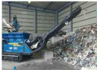
廃プラスチックの破碎処理例
