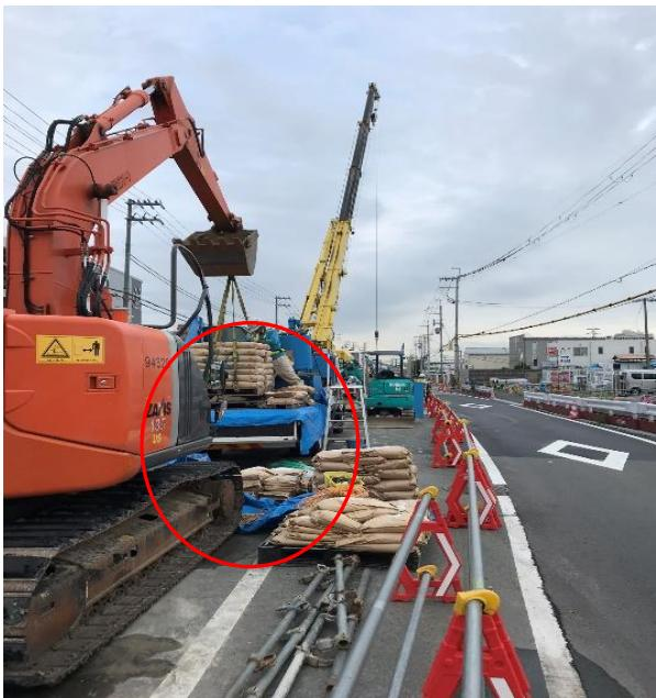
地中障害物(引抜きできずに残置されていた古い鋼矢板)を撤去
