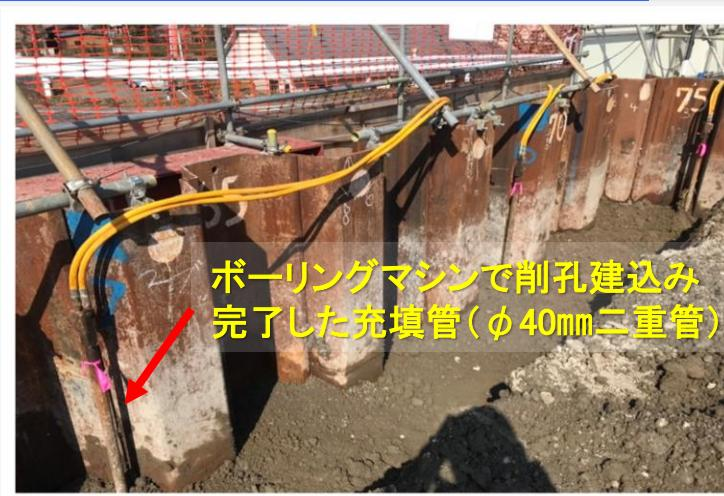
CASE2.鋼矢板打設後に充填管を設置する場合（YT-3B工法）
