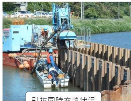
引抜同時充填状況
