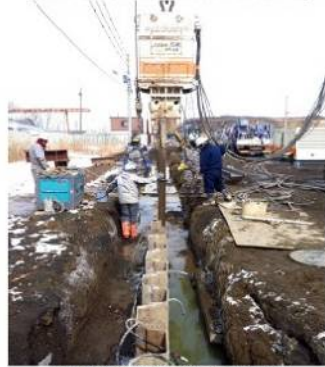
・引抜充填状況(パイプロハンマ)
