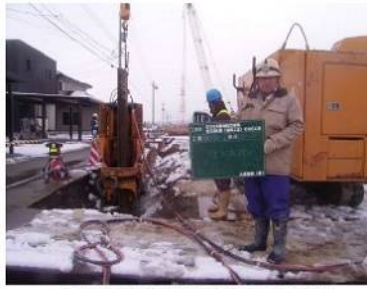
・引抜充填状況(油圧式抗圧入引抜機)
