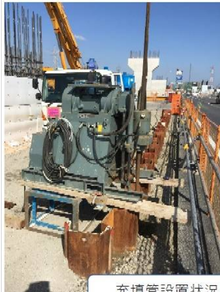
充填管設置状況
