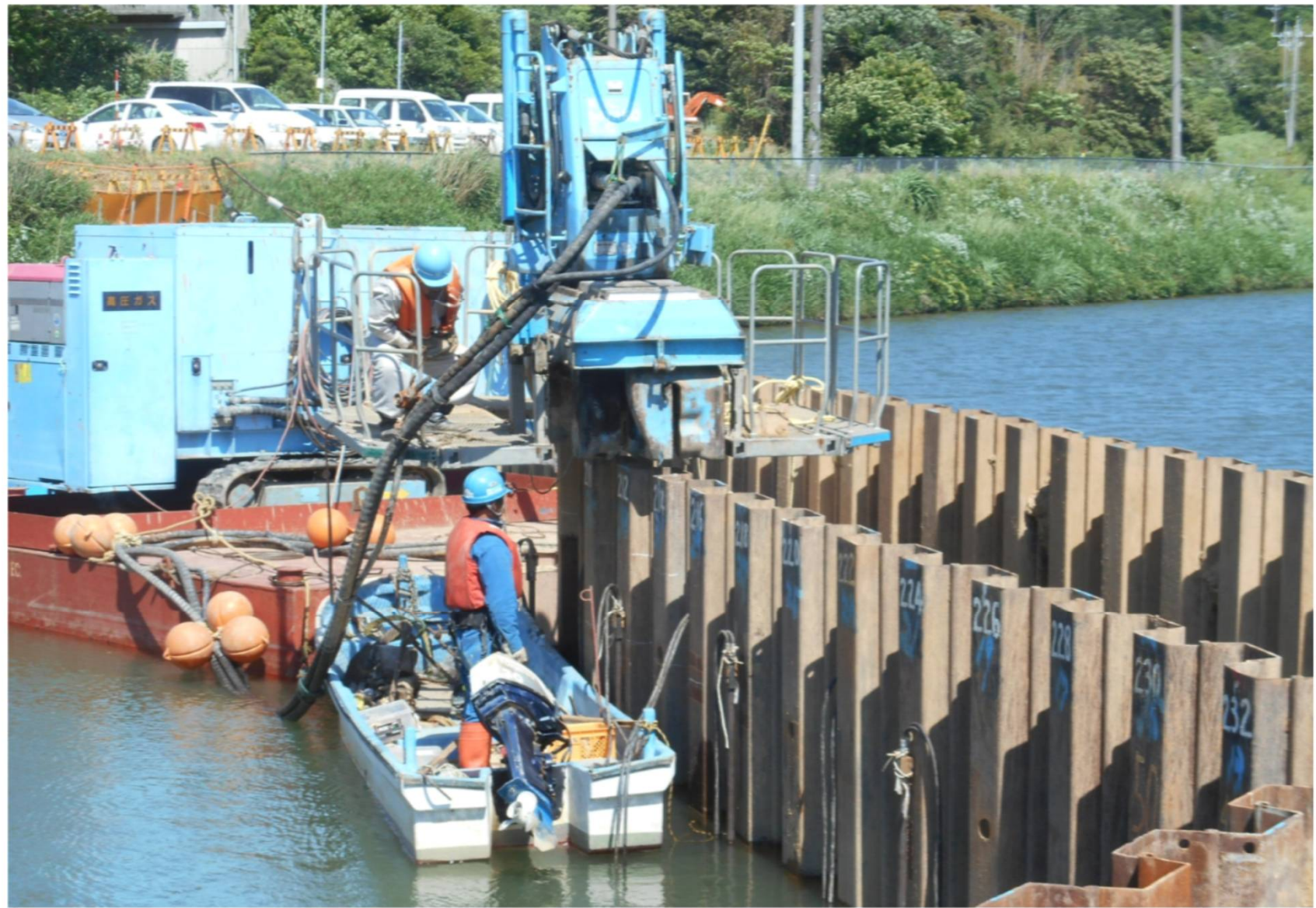
土留部材引抜同時充填工法研究会
