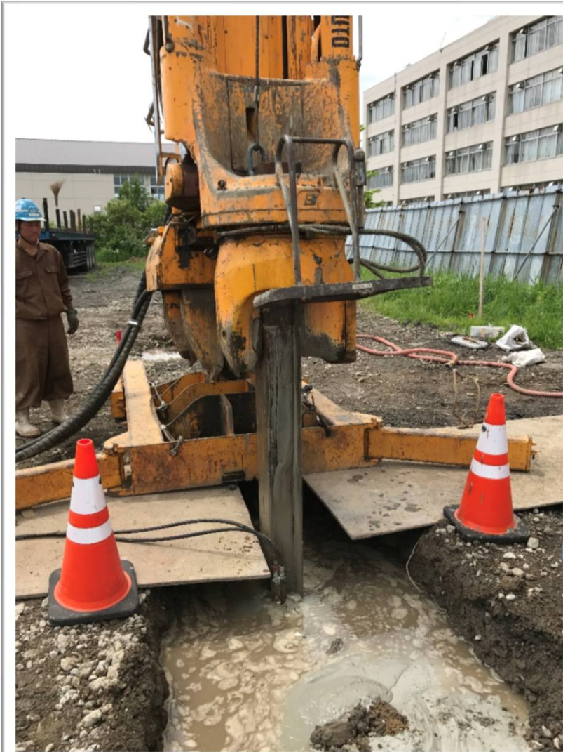
① 引抜同時充填状況
