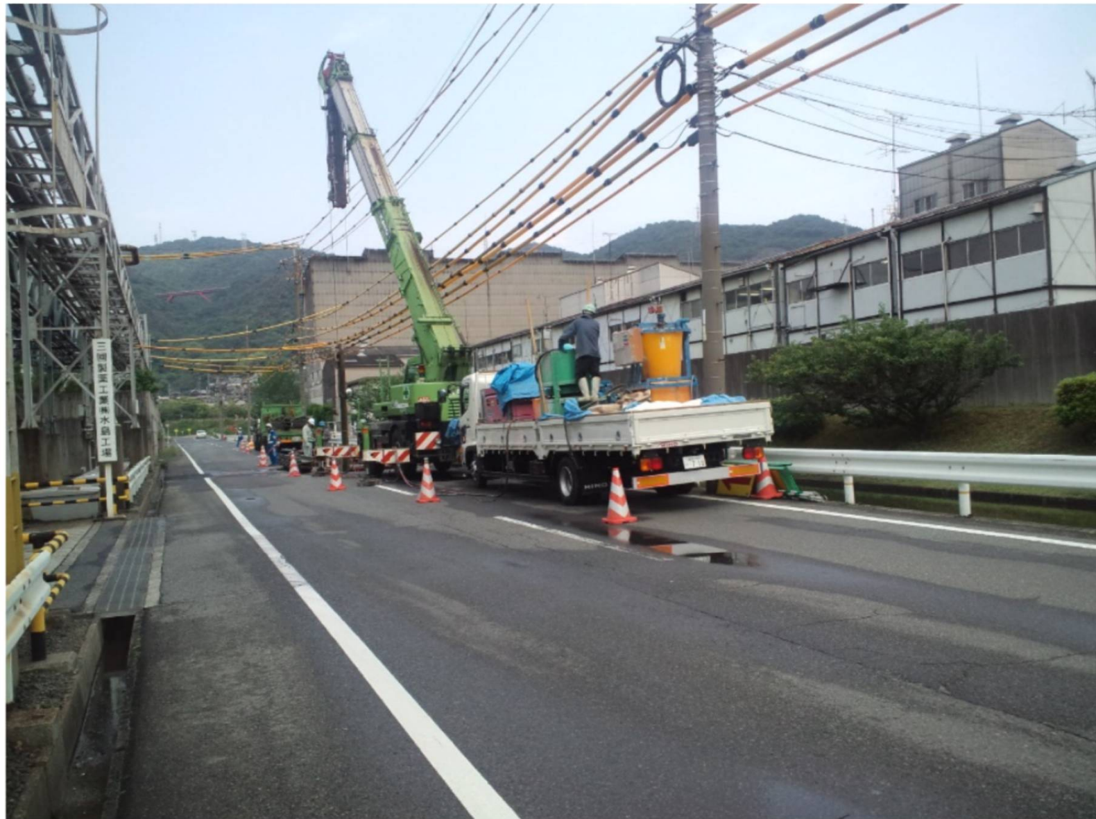
土留部材引抜同時充填工法研究会
