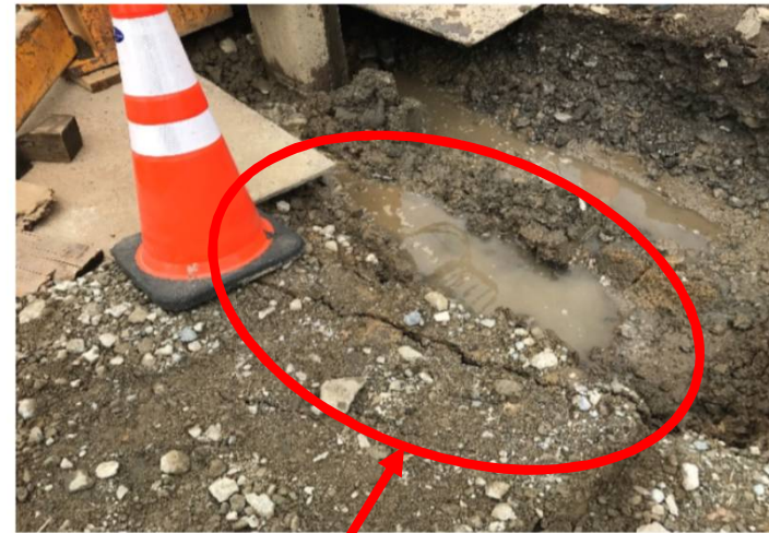
② CB注入前の引抜状況
