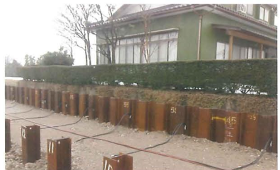
家屋近接工事による家屋への実害発生阻止に採用された例 掘削深さ約0.0m 仕上がり内径2.0mコンクリート管敷設 鋼矢板芯から家屋壁面までの距離3.5m 鋼矢板Ⅲ型
