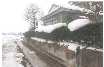
鋼矢板引き抜き後の復旧工事中 家屋擁壁、変位1~2mm、擁壁の養生なしで掘り下げ 水路用U字溝ベースコンクリートの施工がなされている
