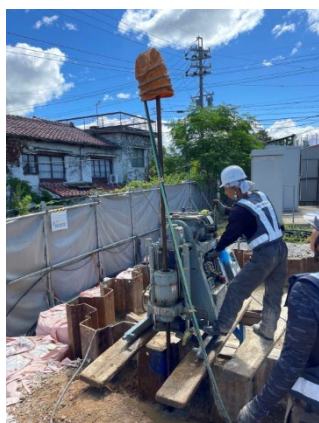
図 3. 充填管設置状況
