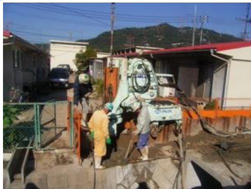
民家際の施工
