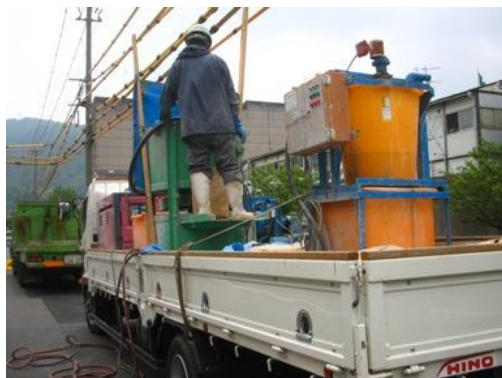
引き抜き注入後、夕方には道路を供用
