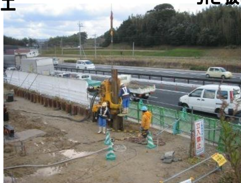
交通量の多い国道(歩道)内での施工
