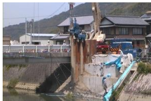
河川での施工
